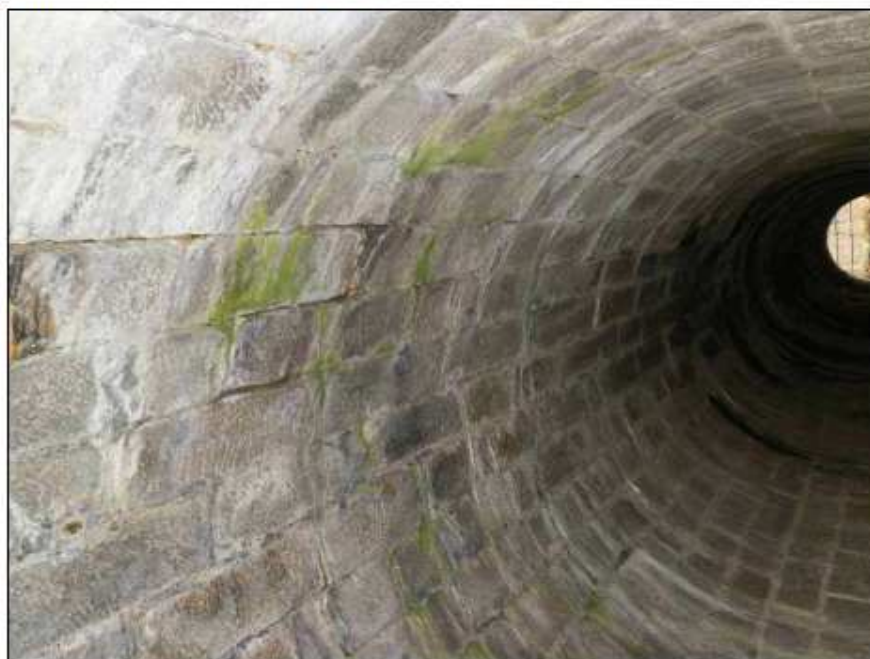
Obr. č. 6 - nosná konstrukce klenba z pravé strany, zdivo je bez poruch, správy jsou místy vypadané a do zdiva zatéká
