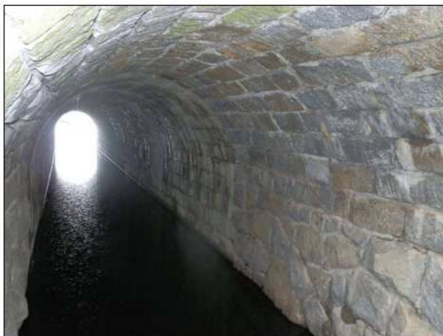
Obr. č. 7 - opěra Strakonice z leva, původní část (řádkové zdivo) byla rozšířena (řádkové zdivo a zdivo z lomového kamene blíže čelu). Zdivo je bez poruch.
