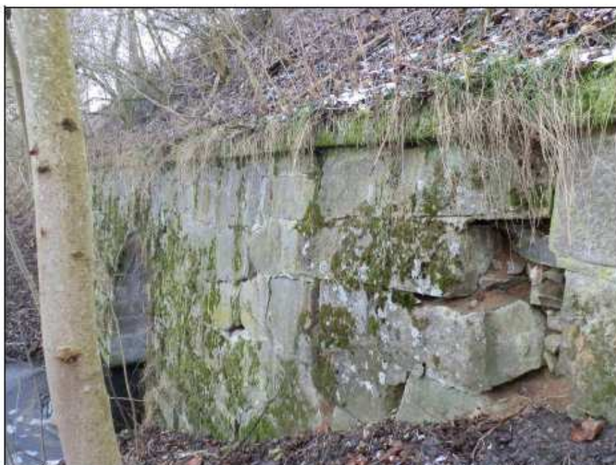
Obr. č. 9 - porucha zdiva pravého čela, zdivo je strukturálně porušené, kameny vypadávají
