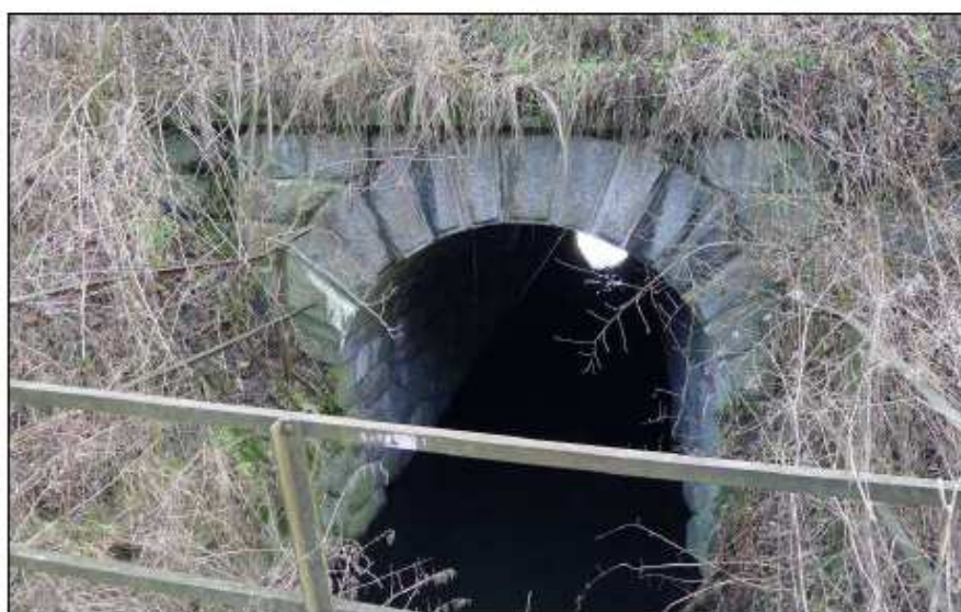
Obr. č. 3 - levé čelo objektu, zdivo je zachovalé, spáry vyspravené, zdivo vlhké
