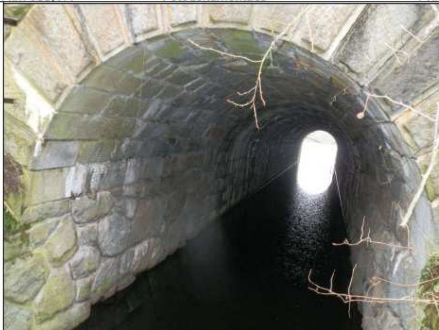
Obr. č. 8 - opěra Nepomuk z leva, původní část (řádkové zdivo) byla rozšířena (řádkové zdivo a zdivo z lomového kamene blíže čelu). Zdivo je bez poruch.
